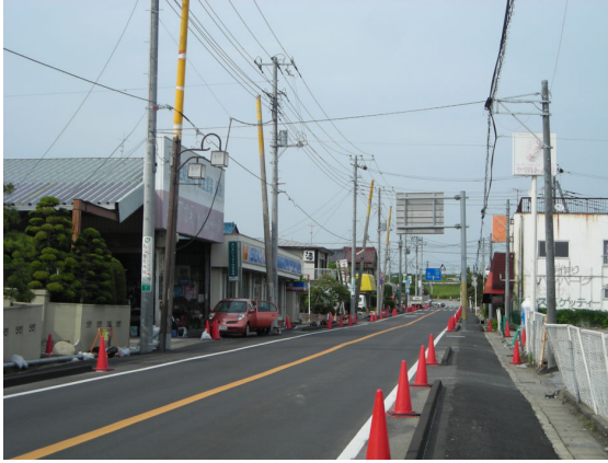
写真1 県道沿いで顕著な被害が出た。電柱の傾きや道路の地波現象が残されている。
