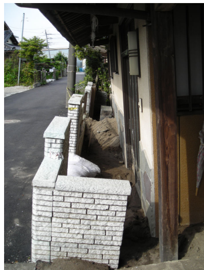
写真5 建物側が沈下して、側壁が建物側に傾いてしまっている。
