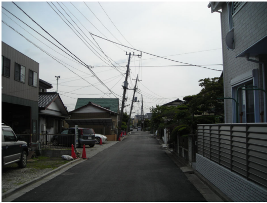
写真3 裏通りに入ると、電柱が傾いている。
