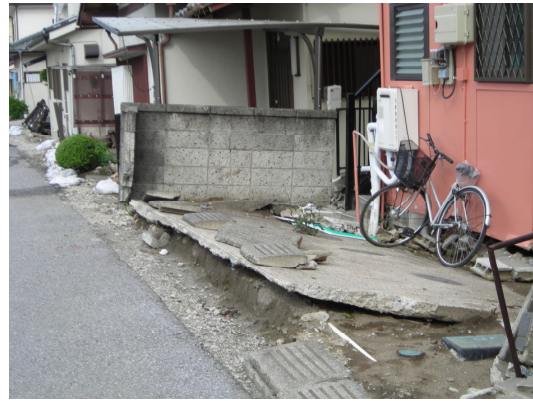
写真2 県道沿い。歩道は修復されているが、建物の部分は沈下している。
