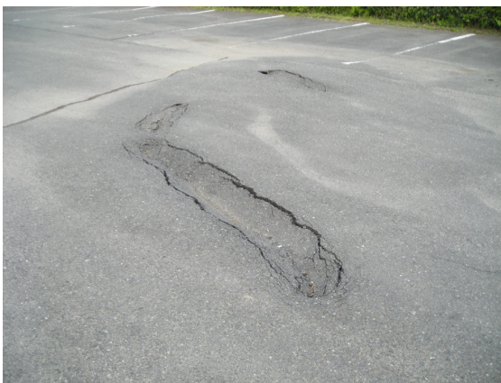
写真13 駐車場での変状。
