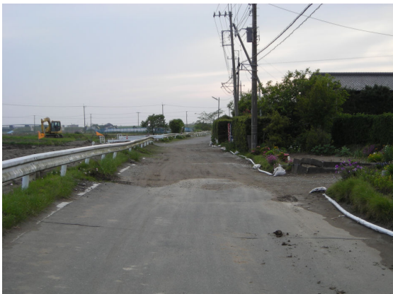
写真11 小河川に沿った道路上で噴砂が認められた。
