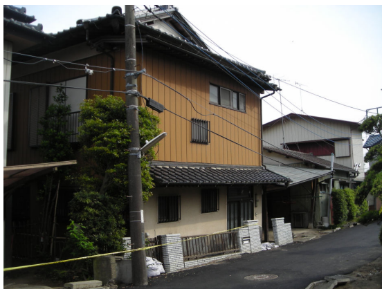
写真5 建物側が沈下して、側壁が建物側に傾いてしまっている。
