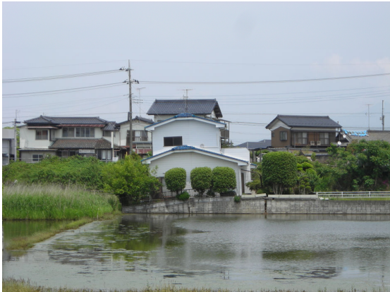
写真7 エリアBの住宅。南西側から撮影。盛土が北東側に傾き、家屋も傾いている。
