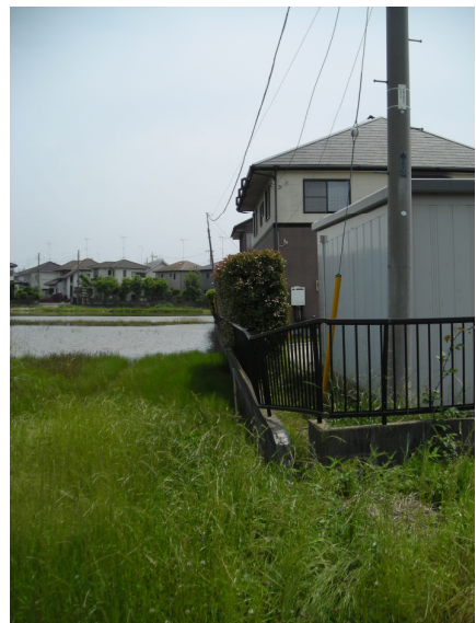
写真5 エリアAの住宅。東側から撮影。盛土が北東側に傾き、家屋も傾いている。
