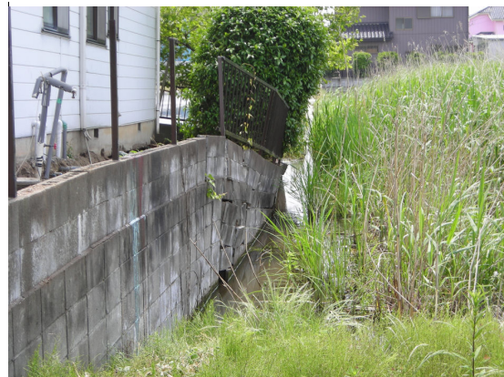
写真7 エリアBの住宅。南西側から撮影。盛土が北東側に傾き、家屋も傾いている。
