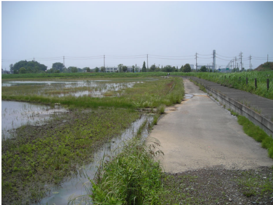
写真1 旧河道内の様子。全体に沈下して水に浸かっている。
