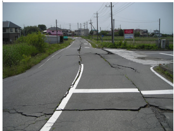
写真1 旧河道内の様子。全体に沈下して水に浸かっている。
