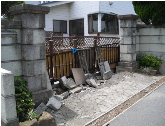
写真9 エリアBの住宅の入口。門や建物が破壊されている。
