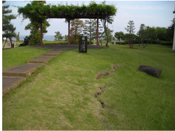
写真3 湖岸側の芝生広場が地盤沈下し、配管施設等が歪んだり、倒れ込んだりしている。抜け上がりの最大量は約30cm。
