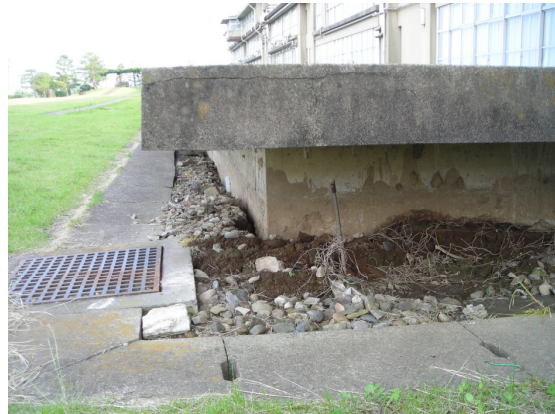
写真1 国民宿舎の公園側の抜け上がりの様子。18cm 抜け上がっている。
