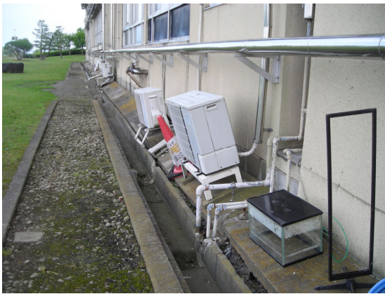
写真3 湖岸側の芝生広場が地盤沈下し、配管施設等が歪んだり、倒れ込んだりしている。抜け上がりの最大量は約30cm。
